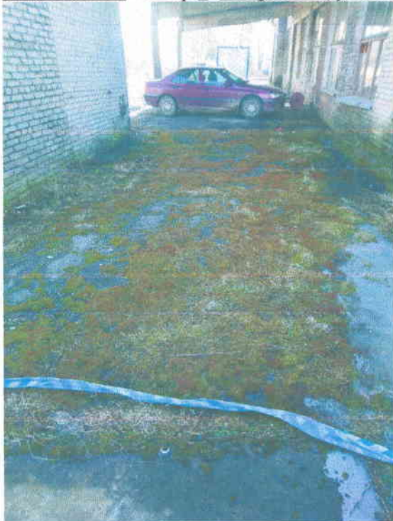
03.03.2022 г. литер а Покрытие (участок 3)
