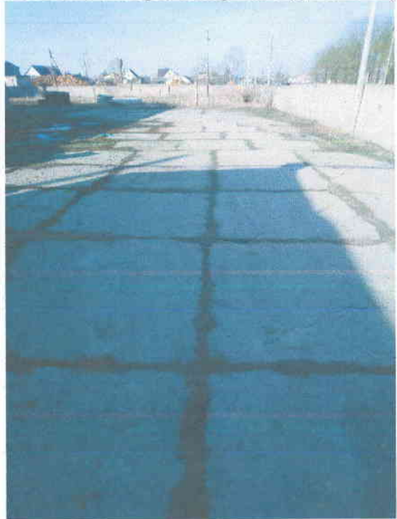
03.03.2022 г. литер б Ограждение
