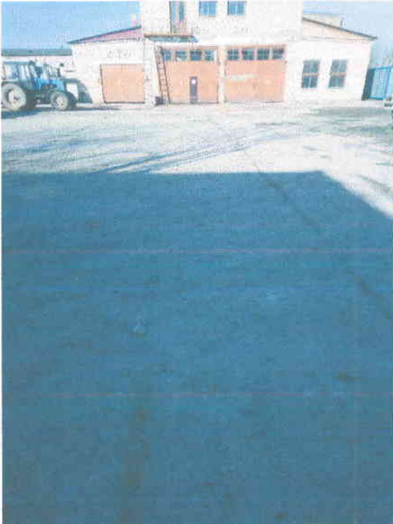
03.03.2022 г. литер а Покрытие (участок 1)
