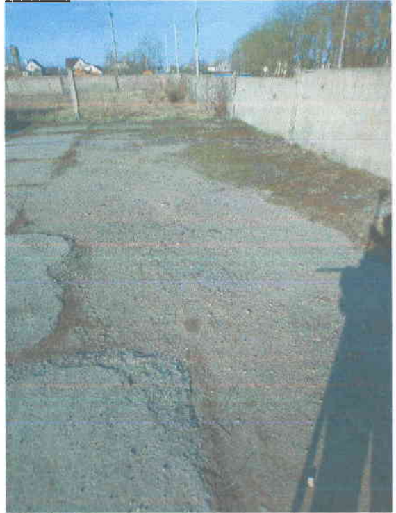
03.03.2022 г. литер а Покрытие (участок 2)
