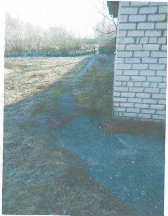
03.03.2022 г. литер а Покрытие (участок 2)
