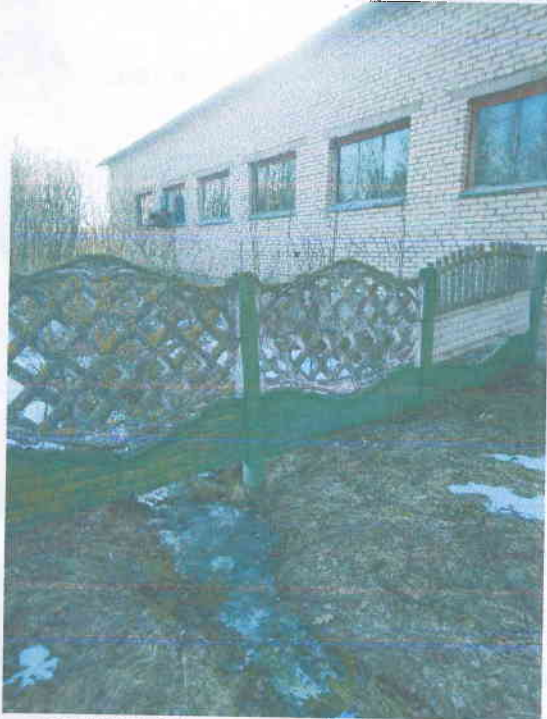
03.03.2022 г. литер б Ограждение
