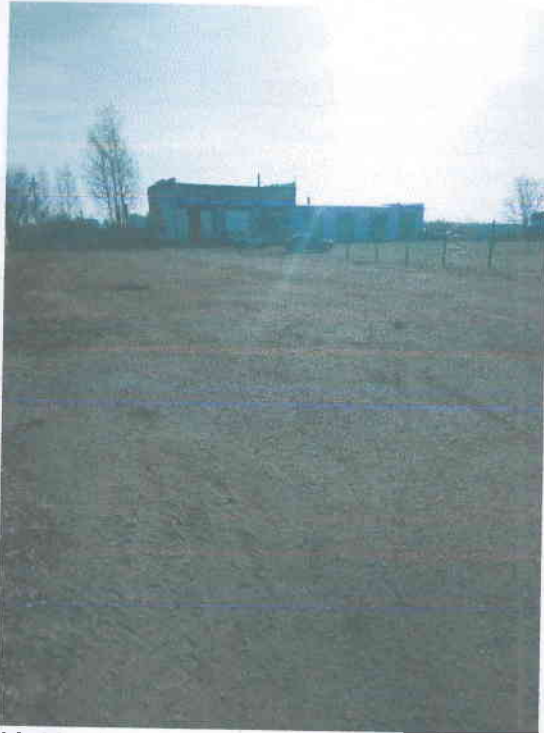
03.03.2022 г. литер а Покрытие (участок 1)
