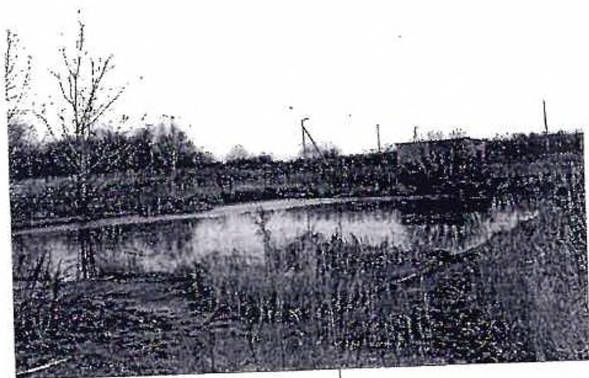
Отстойник дождевых стоков №1 (литера Н)
