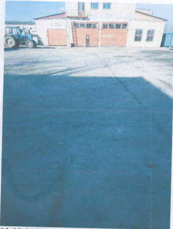
03.03.2022 г. литер а Покрытие (участок 1)
