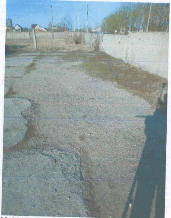
03.03.2022 г. литер а Покрытие (участок 2)
