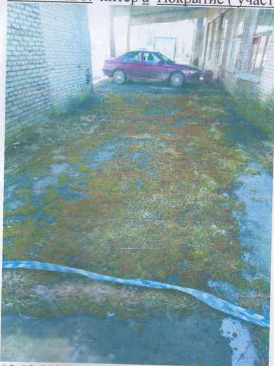
03.03.2022 г. литер а Покрытие (участок 3)
