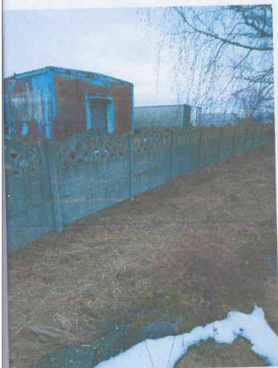
03.03.2022 г. литер б Ограждение (участок 1)
