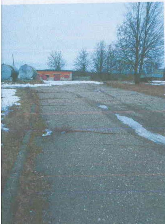
03.03.2022 г. литер а Покрытие (участок 1)
