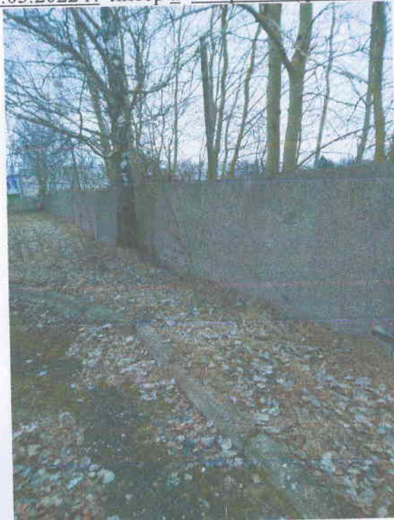
03.03.2022 г. литер б Ограждение (участок 2)
