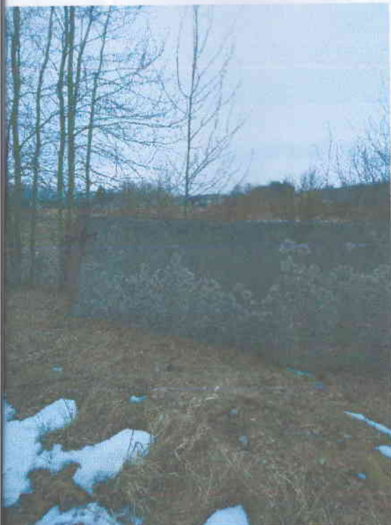
03.03.2022 г. литер б Ограждение (участок 3)
