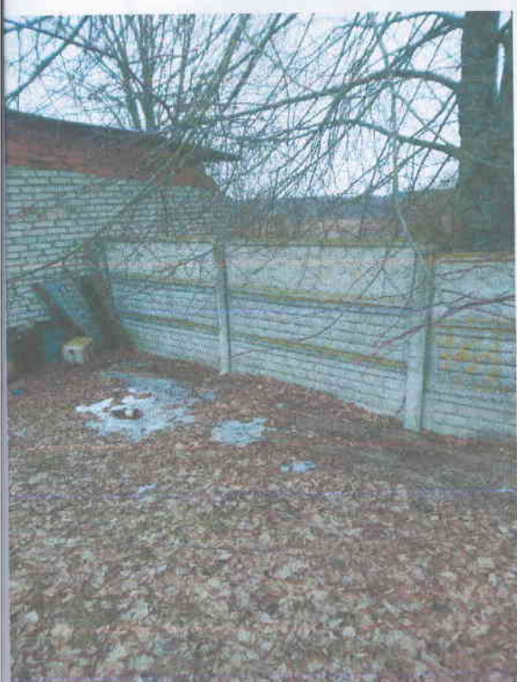
03.03.2022 г. литер б Ограждение (участок 5)
