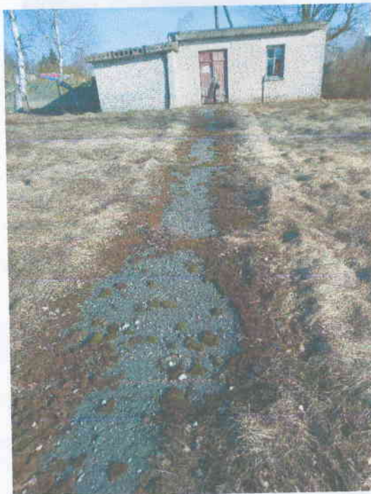
03.03.2022 г. литер а Покрытие (участок 2)
